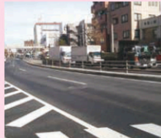
中山道に中央分離帯を設置し横断事故を防止
